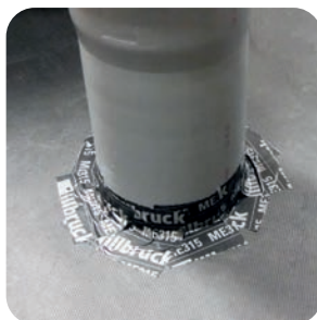
Runde Durchdringung winddicht verklebt außen
