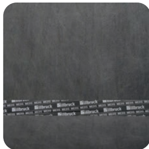
Überlappung winddicht verklebt außen
