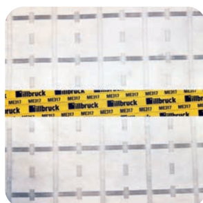
Überlappung luftdicht verklebt innen
