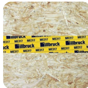
Plattenstoß luftdicht verklebt innen
